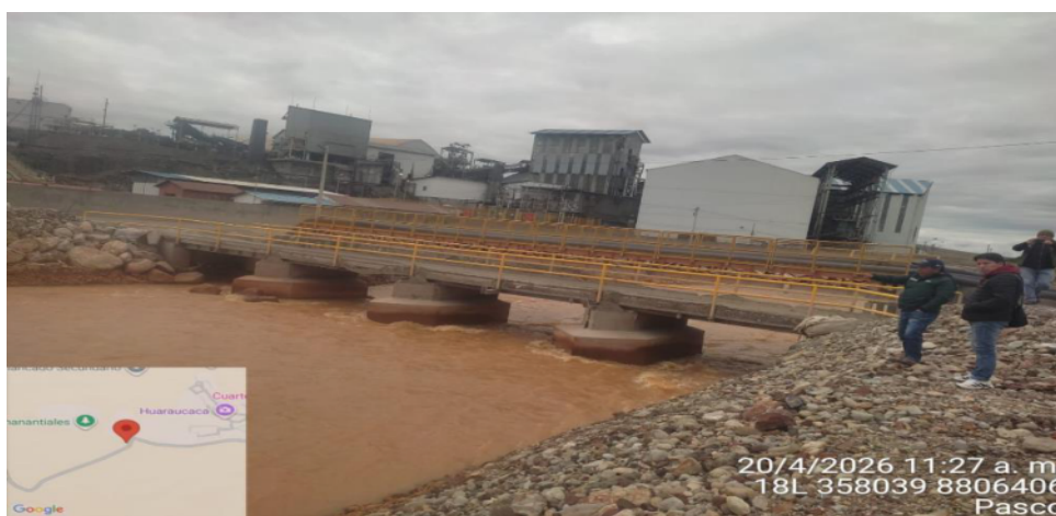
IMAGEN 04: SE OBSERVA EL PUENTE Y EN LA PARTE POSTERIOR TUBERIAS CON RELAVEZ MINEROS, EL PUENTE PRESENTA BAJA ALTURA EN EPOCAS DE AVENIDAS EL AGUA SE DESBORDA POR ENCIMA DEL PUENTE
