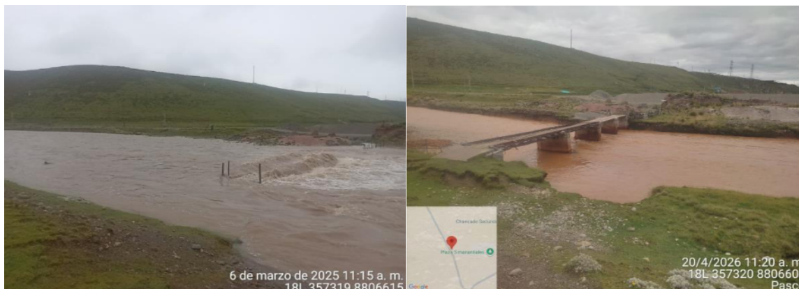
IMAGEN 02: EL CAUDAL DEL RIO SAN JUAN, HA SOBREPASADO EL CAUCE NATURAL INUNDANDO Y EROSIONANDO PARTE DE LA PLATAFORMA DE LA CARRETERA, Y EL PUENTE PEATONAL DEL SECTOR HUARAUCA. COMO SE PUEDE OBSERVAR EN AMBAS IMAGENES DEL 2025 Y 2026.
